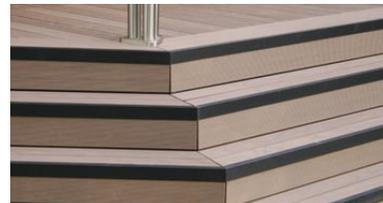
Abblendleiste mit TOAX-Schrauben V2A (V4A optional)
